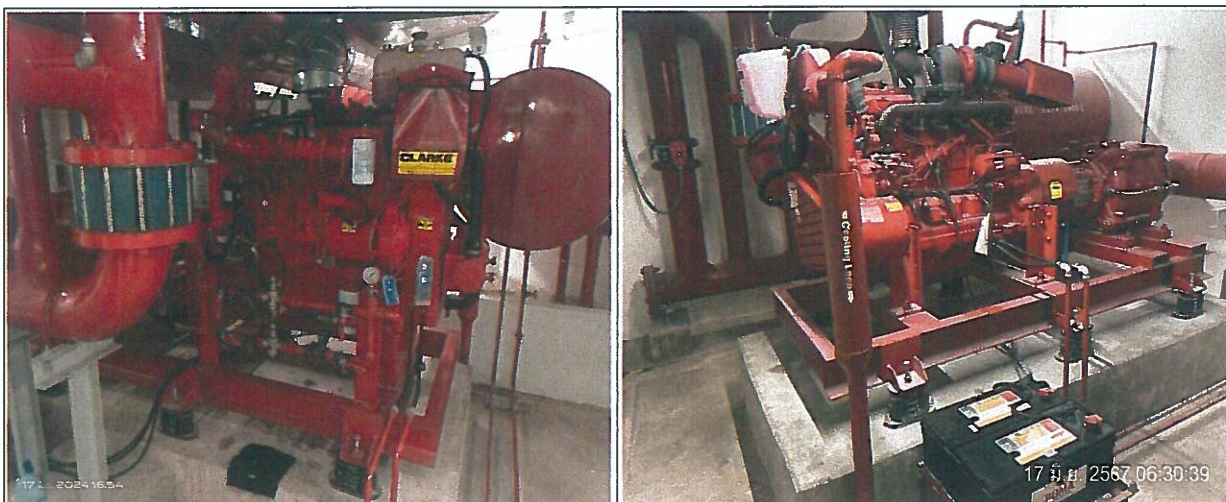
ภาพที่ 29 เครื่องสูบน้ำดับเพลิง
